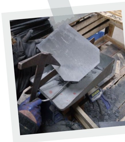
Chaque ardoise est taillée à la main par l'entreprise Guillaneuf couverture puis fixée grâce à des clous en cuivre crantés (plus robustes car ne rouillent pas)
