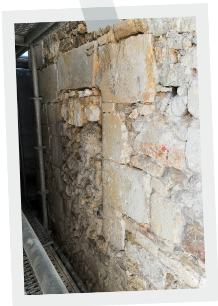
Découverte d'une ancienne porte lors du piochage des enduits
