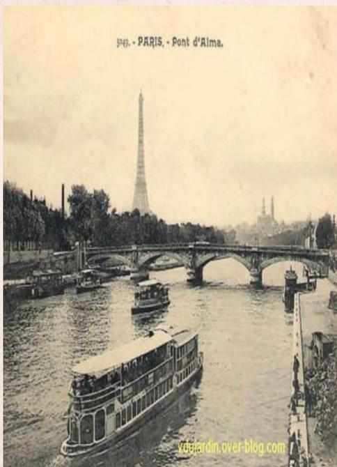
Suite aux inondations de 1910, on constata des affaissements, le pont constituait un dangereux obstacle pour l'écoulement des crues. En 1910 l'eau atteignait la clé de voûtes de l'arche centrale. Le pont était une gêne considérable à la navigation.
